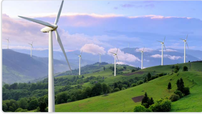
Görsel 1.9: Rüzgâr türbini
